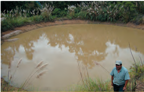
Atajado de agua de lluvia con capacidad de 200.000 lts. de agua
