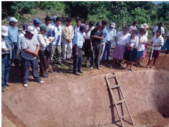
Construcción de reservorio de agua y visita de productores
