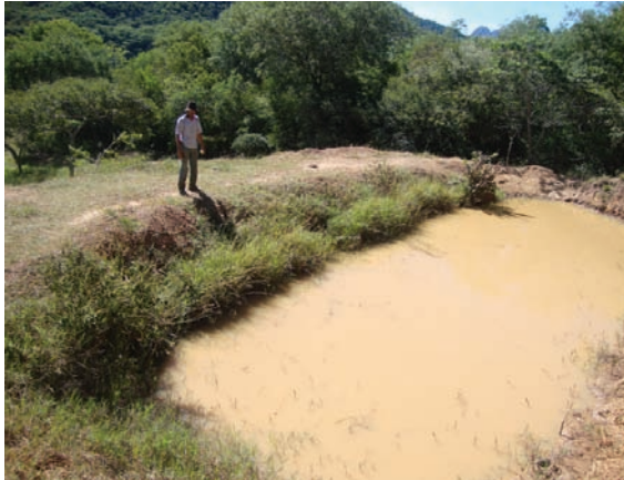
Atajado para cosechar agua de lluvia ubicado en la parte alta de la parcela
