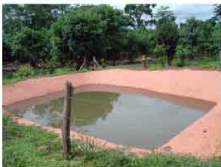
Reservorio de agua lleno listo para su uso
